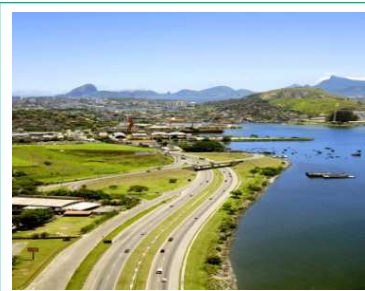
Autopista Fluminense Arteris
