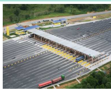
Autopista Planalto Sul Arteris
