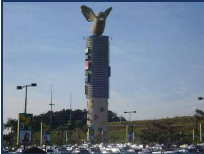
ASPECTOS DA CAIXA D'ÁGUA
