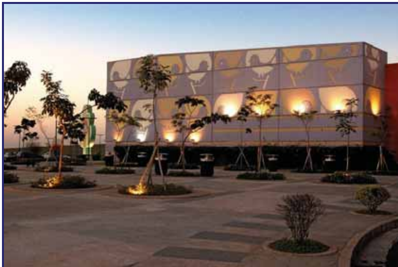
ASPECTOS DA FACHADA
