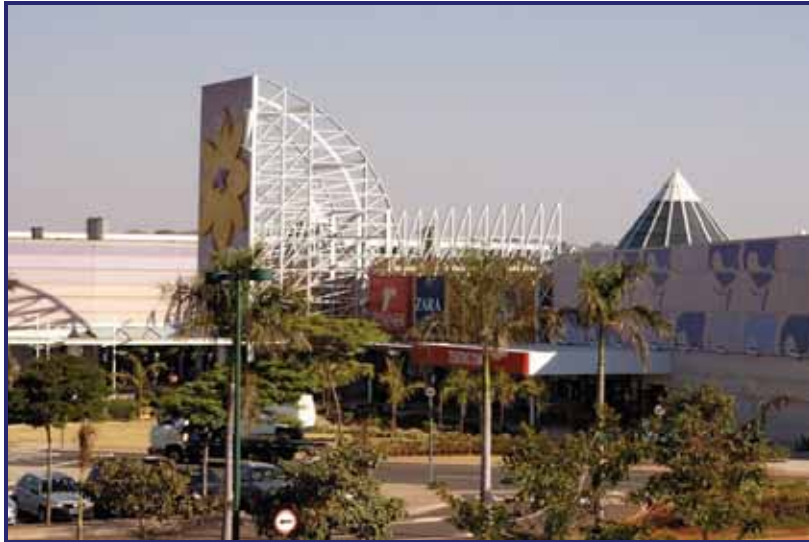
ASPECTOS DA FACHADA
