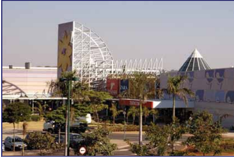
ASPECTOS DA FACHADA
