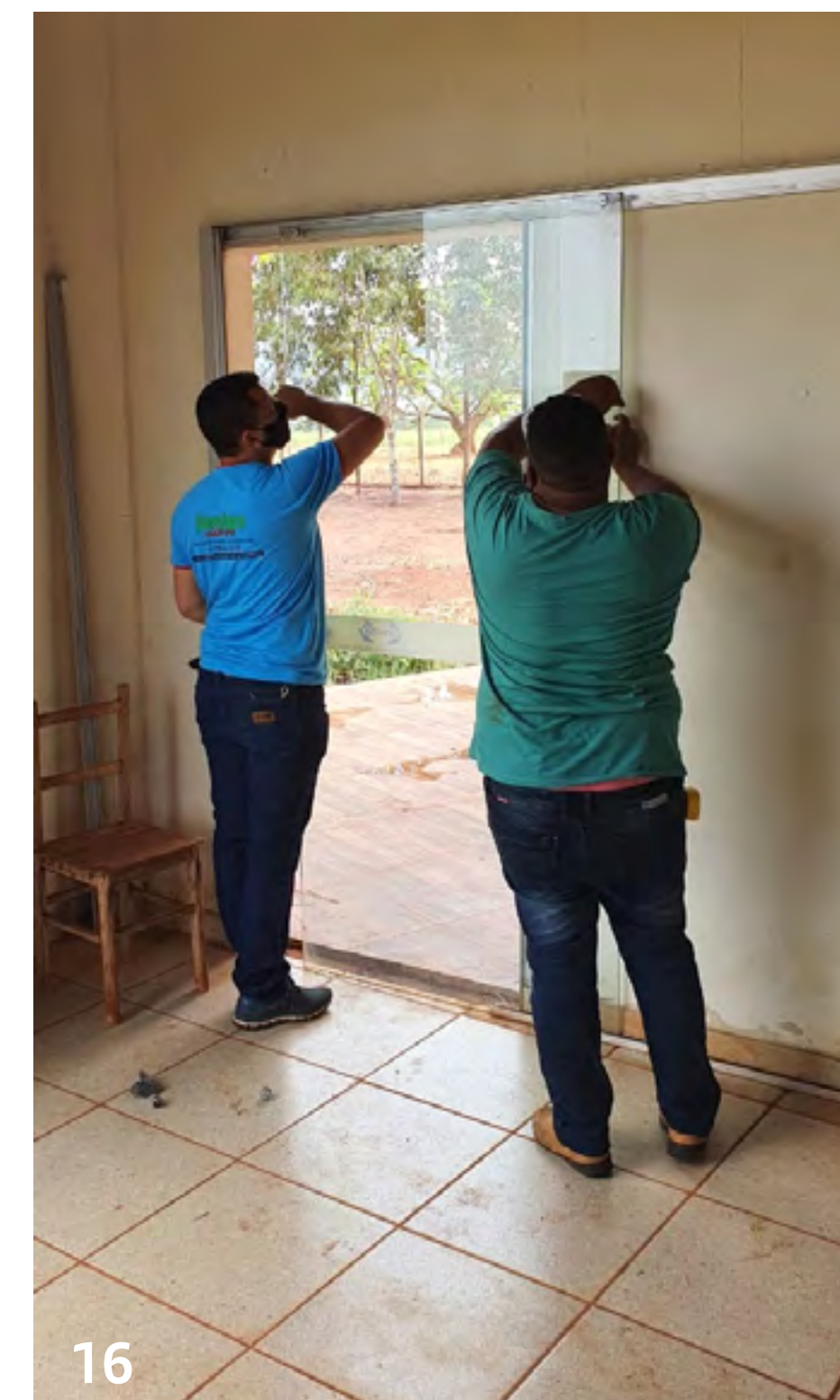
Imagem 16 – Reforma do espaço de atendimento em Ituiutaba (MG)
