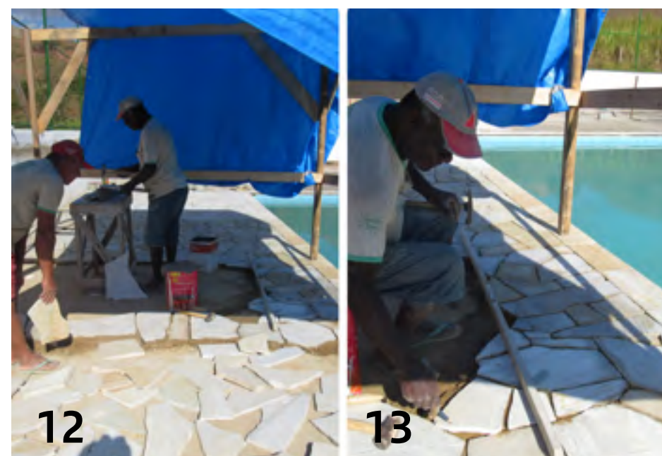
Imagens 12 e 13 – Reforma do espaço de atendimento em Ubá (MG)
